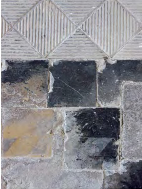
7 Wirtschaftsgebäude Schloss Güstrow, Fliesen im Erdgeschoss
