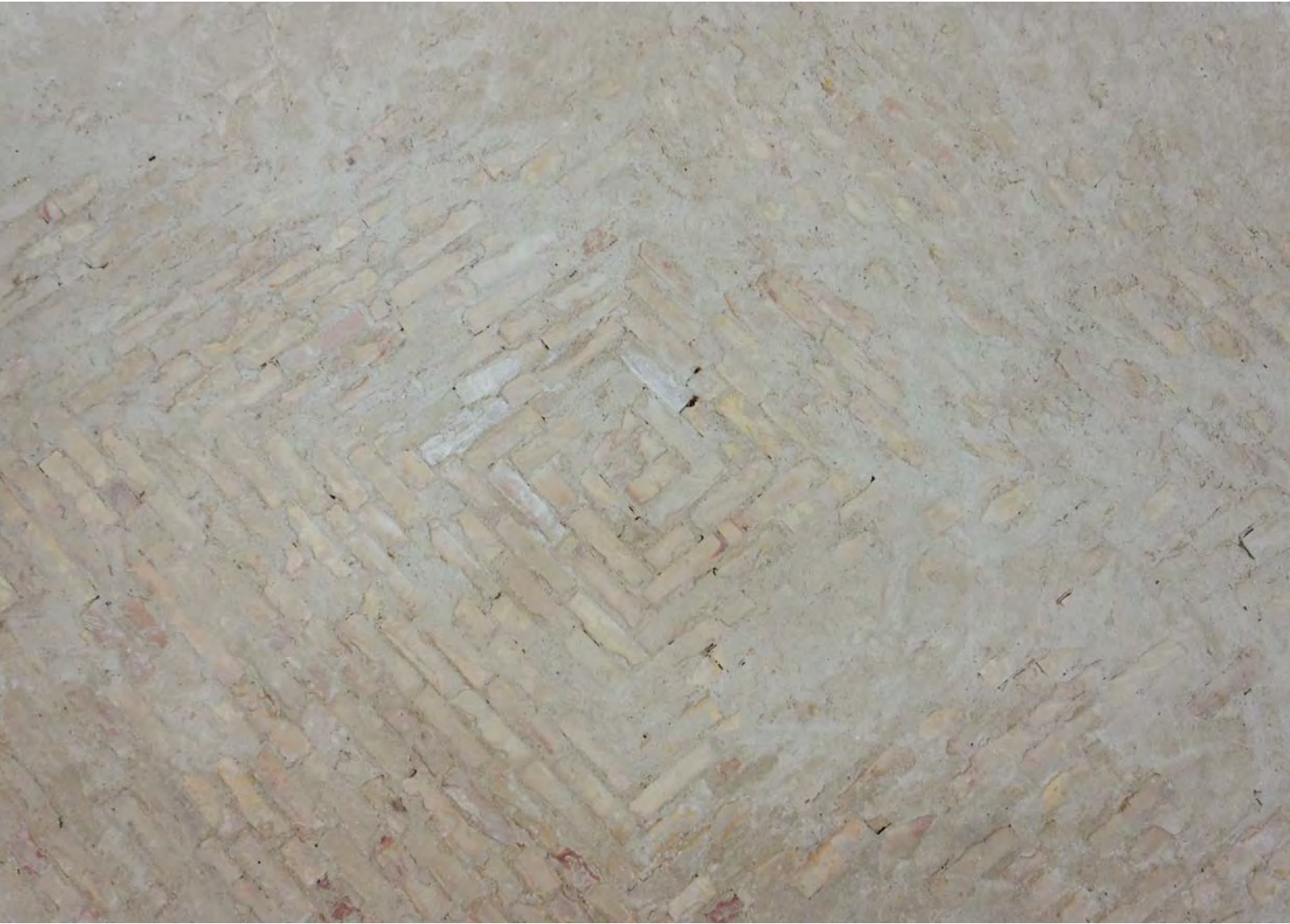
54 Gewölbe, westl. Erdgeschossraum, Wirtschaftsgebäude
